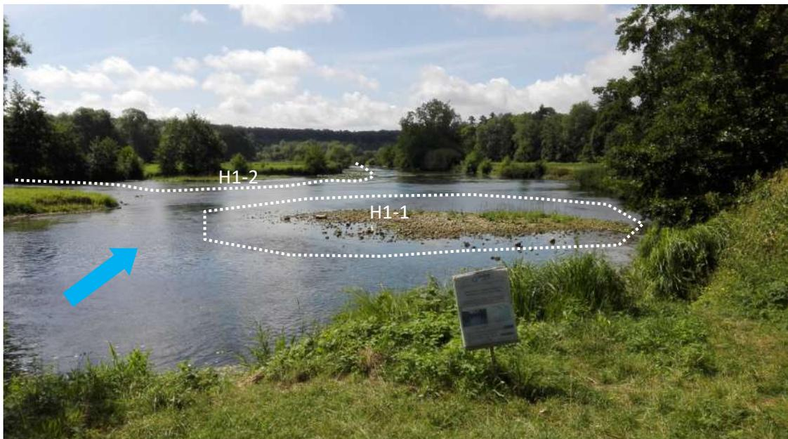
De l'île, jusqu'à la limite aval de cette banquette des blocs épars de taille 400-500 seront répartis dans le cours du Loir pour limiter les vitesses et offrir des caches pour la faune piscicole. L'arbre présent dans le lit du Loir en amont de l'aménagement sera retiré.
