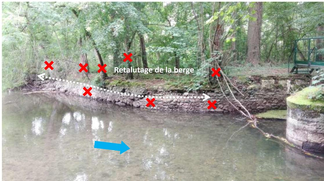
Figure 25 : Restauration des berges rive droite en amont du vannage de la Guimande
