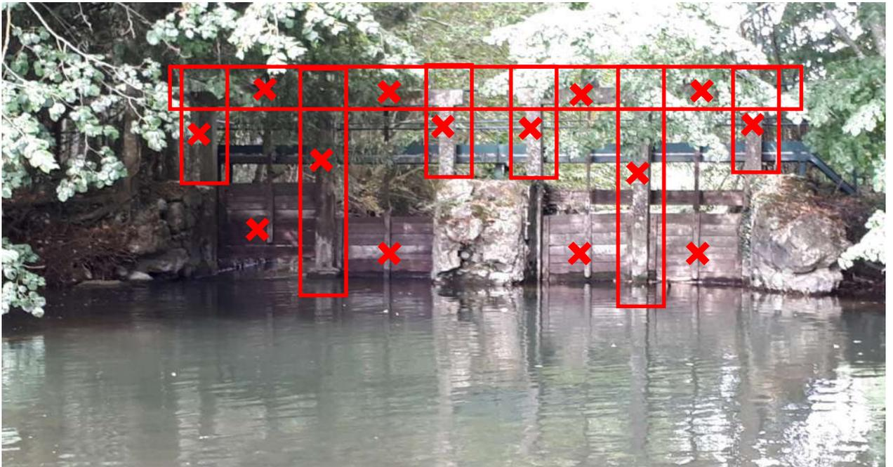
Au vu du fort état de dégradation des maçonneries, il est probable que ce mauvais état s'accroisse du fait de la baisse du niveau d'eau. Les maçonneries les plus dégradées seront donc démontées : elles seront uniquement conservées sur 5 ml en amont et aval de la passerelle. Des blocs, de taille 300-400, pourront être déposés en pied de berges pour le protéger.
