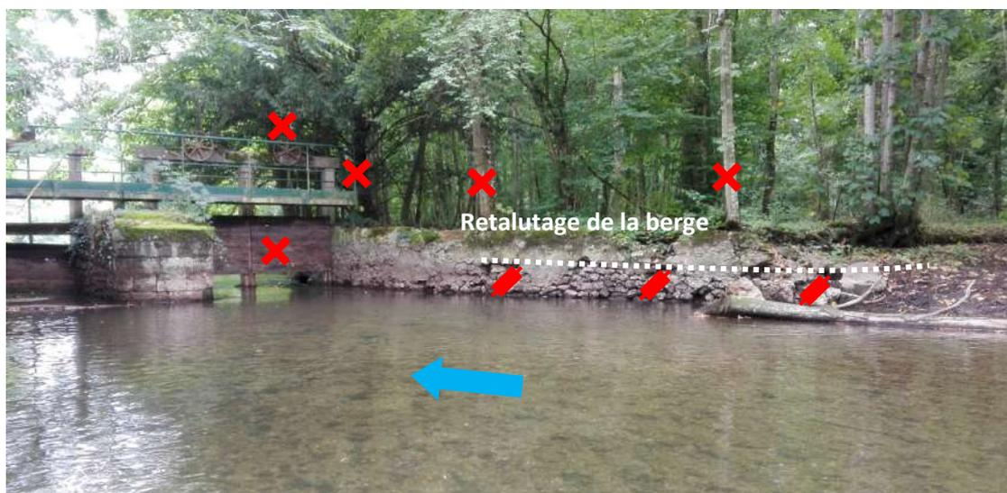
Une recharge sédimentaire et des blocs seront mis en place au niveau de l'ouvrage pour favoriser le passage de l'eau l'été au niveau d'un seul passage. Une fois les ouvrages démontés et un hiver passé, le passage concerné sera choisi pour conserver celui où un meilleur équilibre se sera formé.
