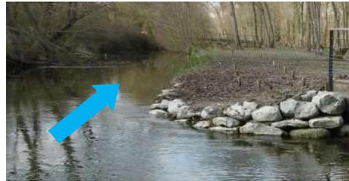
En complément du retrait des protections de berge, des banquettes végétalisées seront mises en place dans le prolongement de cet îlot afin de resserrer les écoulements et permettre une lame d'eau plus importante lors des étiages sévères. La hauteur moyenne de la banquette sera de 40 cm pour atteindre la cote de 98,25 mNGF. La surface concernée par cet aménagement est de 130 m<sup>2</sup>. Le volume de matériaux utilisé est estimé à 82 tonnes.
